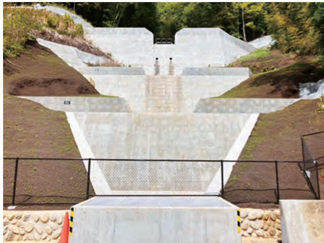
完成した砂防堰堤
