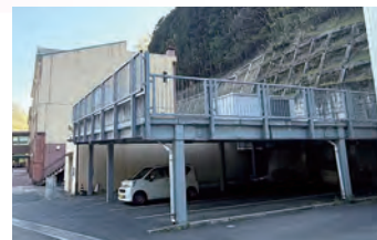
やすらぎの里駐車場
