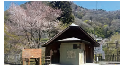
払沢の滝入口のトイレ
