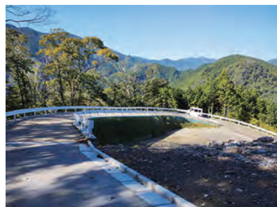
工事が進んでいる立山林道
