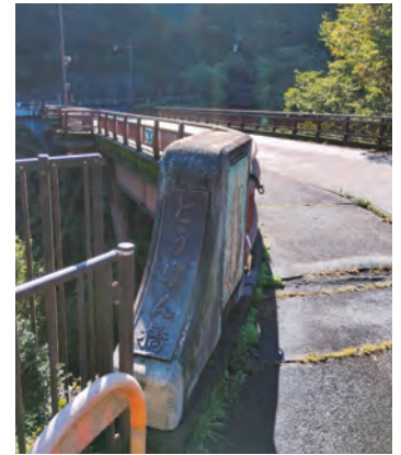
耐震補強工事が 予定されているとうげん橋
