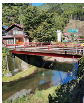
補修が予定されている小沢橋
