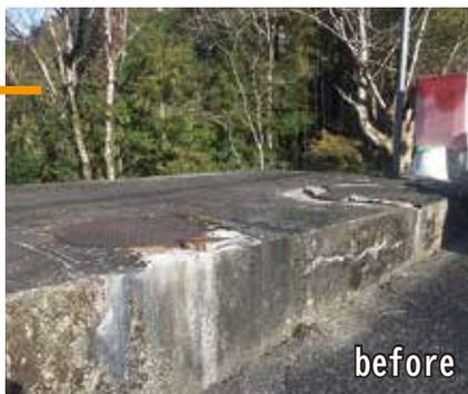
老朽化でひび割れた防火水槽
