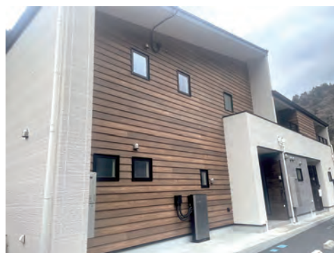
千足地区に建設された「檜原村移住体験住宅」
