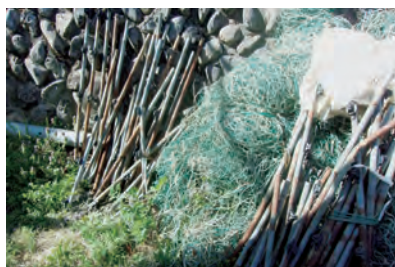
老朽化により撤去された防護柵
