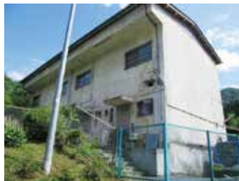
取り壊し前の村営住宅
