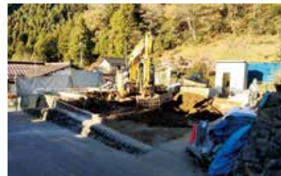
取り壊し作業中の様子
