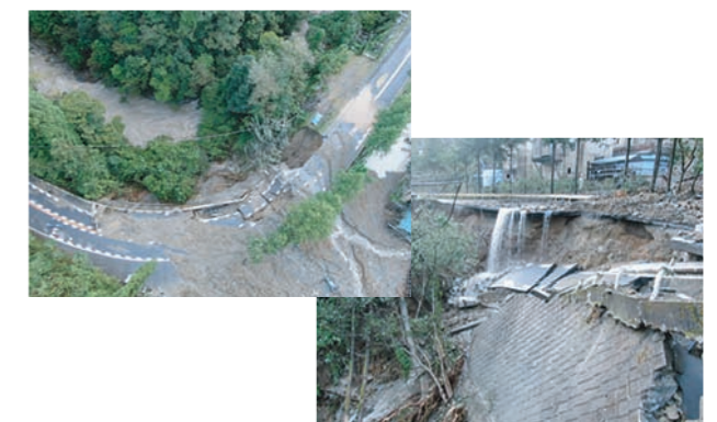
令和元年の台風19号による村内の土砂災害の様子
