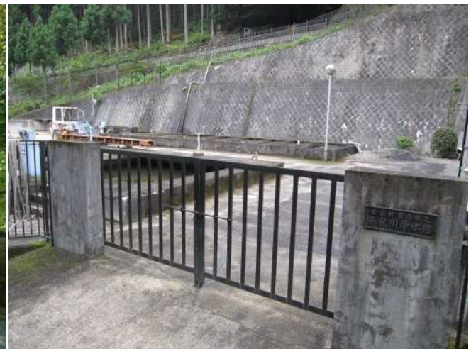
南秋川浄水場
