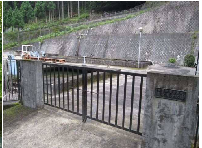
南秋川浄水場
