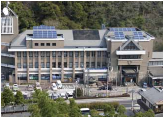
役場庁舎屋上に設置された太陽光パネル
