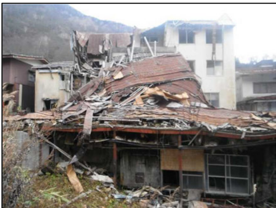
著しく景観を損なっている状態
