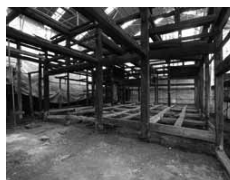
国指定重要文化財 保存修理運搬設備工事
