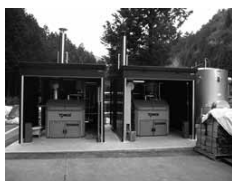
薪ボイラー設置工事
