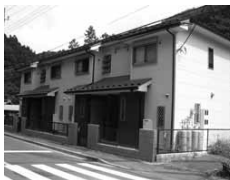
村営住宅建設工事
