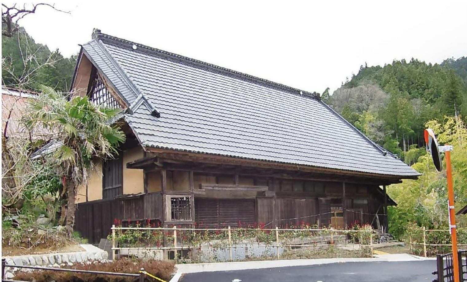
改修が進む国登録有形文化財 旧高橋家住宅主屋（人里地区）
