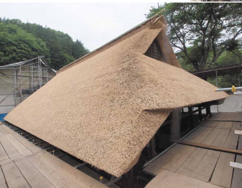
茅葺屋根が葺きあがった状態
