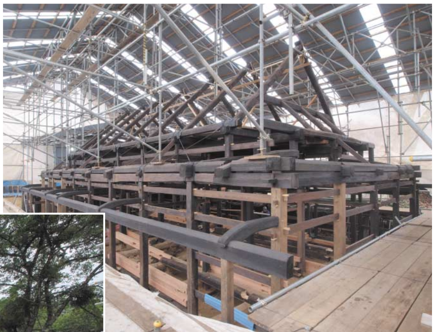
軸組組立工事が完了した状態
